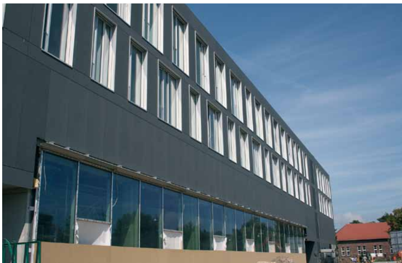
Außenansicht Neubau ZLR III in Wildau, Stand August 2011
